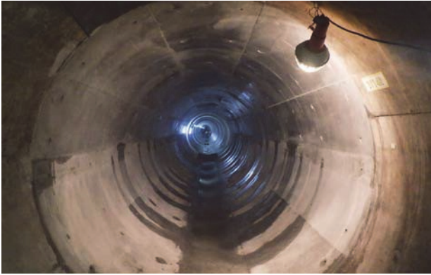
写真-3 地中接合部覆工完了
