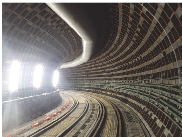
写真-2 発進直後の急曲線（IP.1：R=18m,IA=121-29-10）
