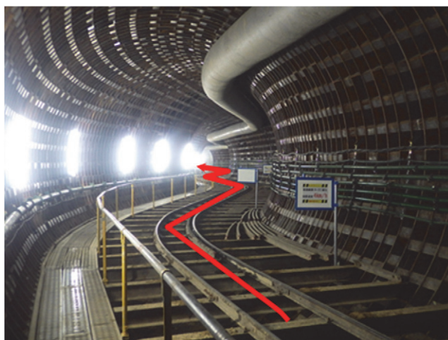
写真-3 4つの連続急曲線（IP.10～13：R=18m,20m）
