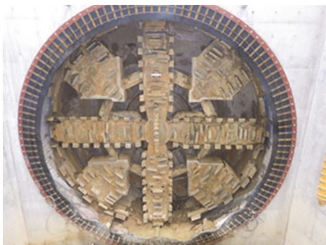
写真-4 シールド機到達状況
