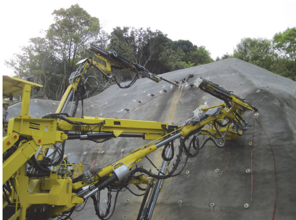
写真-6 軽量鋼管の施工状況（Mトンネル）
