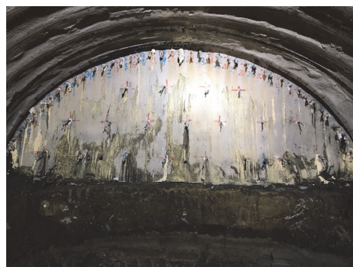
写真-4 軽量鋼管の打設完了状況
