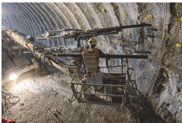
写真-5 軽量鋼管の施工状況（Hトンネル）
