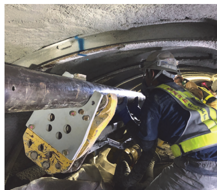
写真-8 軽量鋼管の施工状況（Oトンネル）
