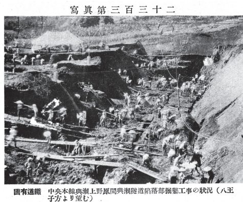
図-4 中央本線与瀬―上野原間の与瀬トンネル陥落部掘削工事 4)
