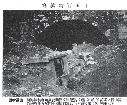
図-1 熱海線真鶴―根府川間寒ノ目山トンネル坑門斜面崩壊 4)
