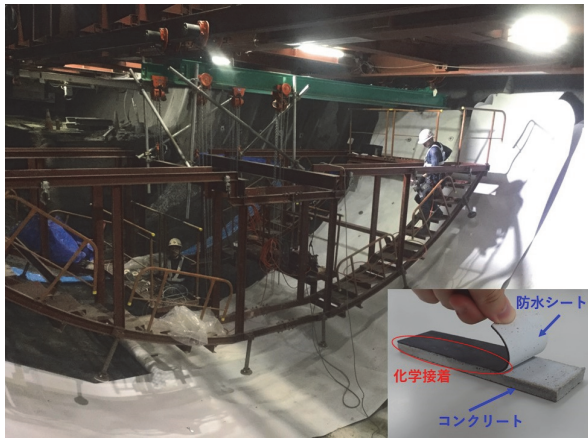
写真-1 インバート防水シート施工状況
