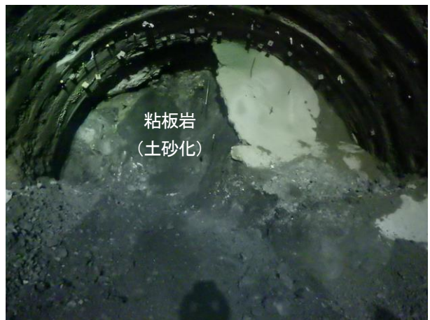
写真-4 破碎帯掘削状況（464km804m）
