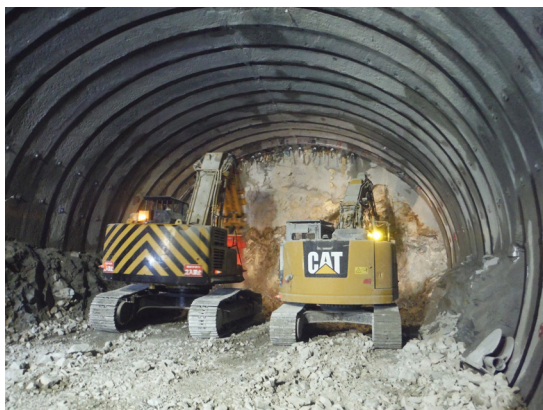
写真-7 トンネル掘削状況（2 t 級+4 t 級）
