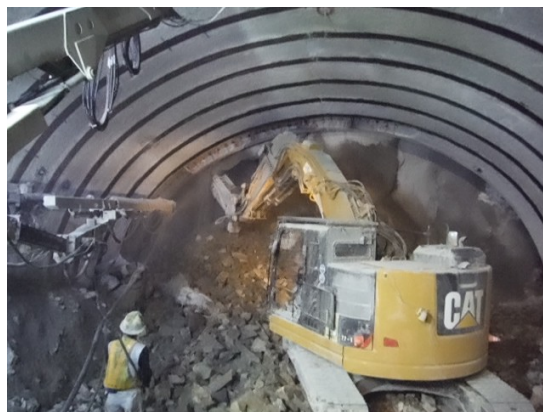
写真-4 分割施工実施状況
