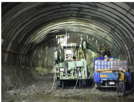
写真-6 補助工法施工状況
