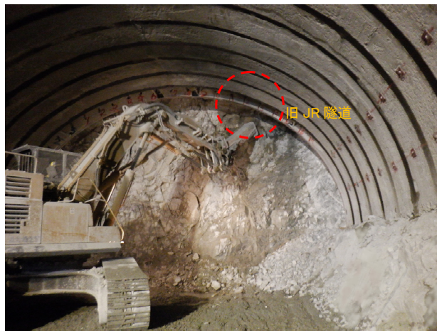
写真-8 トンネル掘削状況（支保 No. 167：TD167m）
