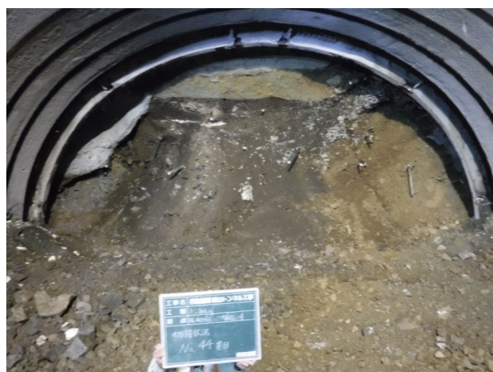
写真-3 切羽状況（支保 No. 44 : TD44m）
