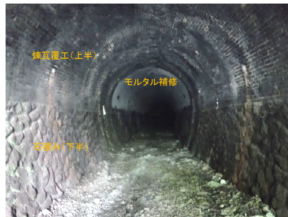
写真-1 旧JR隧道対策前
