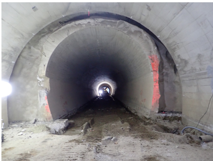
写真-1 清水トンネル拡幅未施工区間
