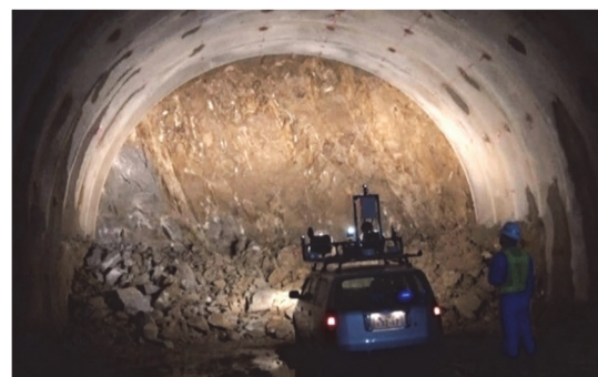
写真-8 計測車両を用いたデータ取得状況
