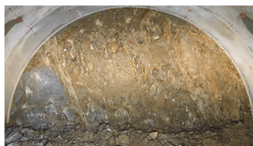
写真-2 風化度評価を行った切羽（可視光線）
