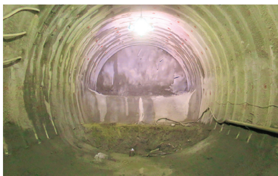
写真-6 一次インバートによる早期併合状況
