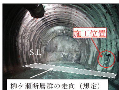
写真-1 中尺コアボーリングの施工位置
