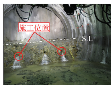
写真-2 削孔検層の施工位置
