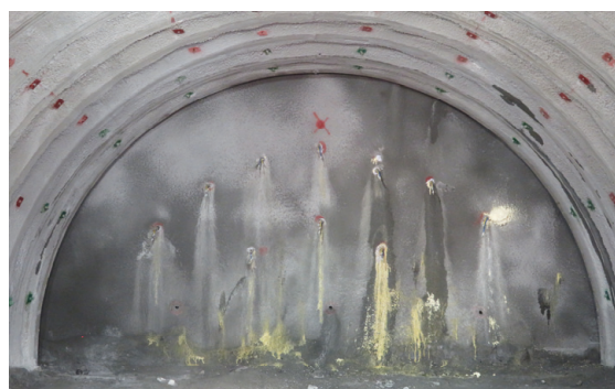
写真-7 長尺鏡ボルト施工状況
