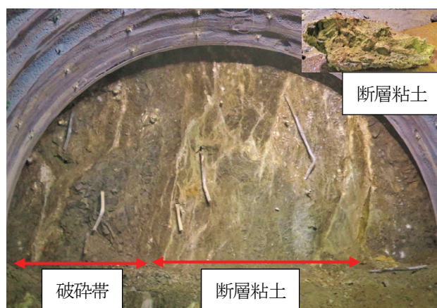
写真-5 断層粘土・破碎帯の切羽
