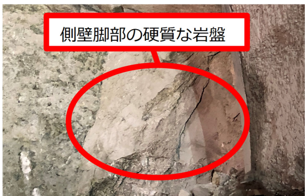
写真-9 側壁脚部の硬質な岩盤
