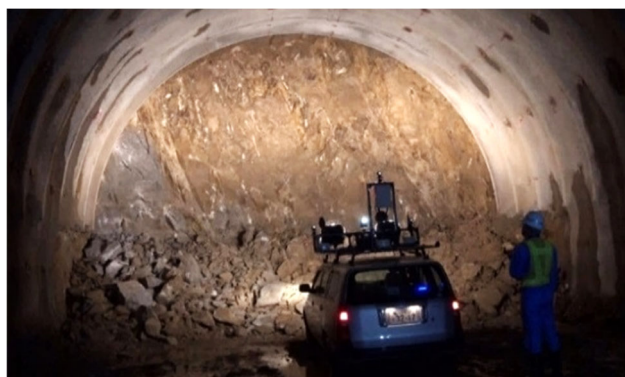
写真-4 掘削出来形・地質データの取得状況
