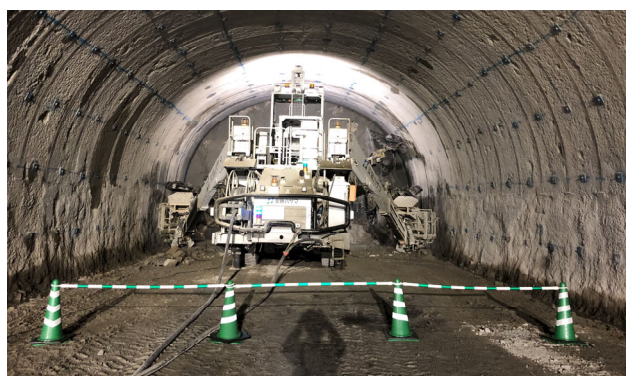
写真-8 遠隔で操作される MG ジャンボ
