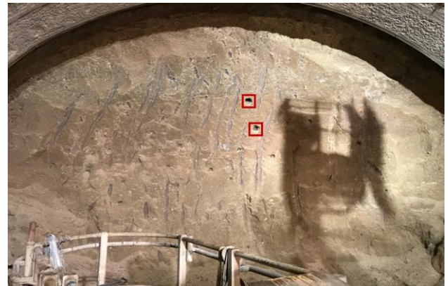
図-12 計測した切羽面
