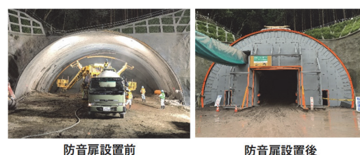
図-14 防音扉設置前後の様子
