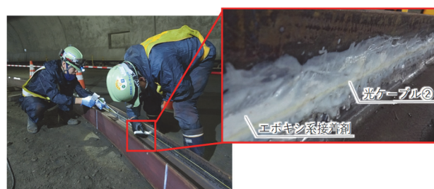
写真-2 鋼製支保工への貼付け
