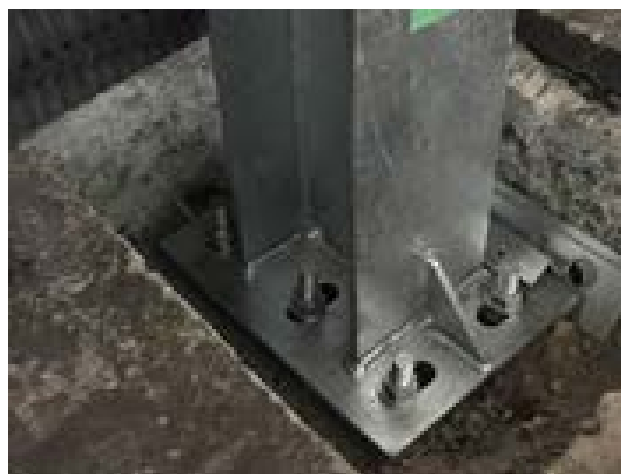
写真-5 柱下端での高さ調整
