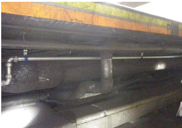
写真-7 ホーム下施設物状況
