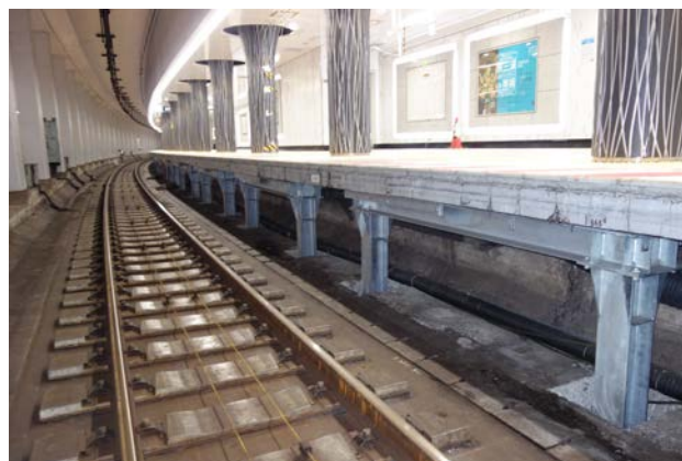
写真-2 鋼材による柱補強（日比谷線土野駅）
