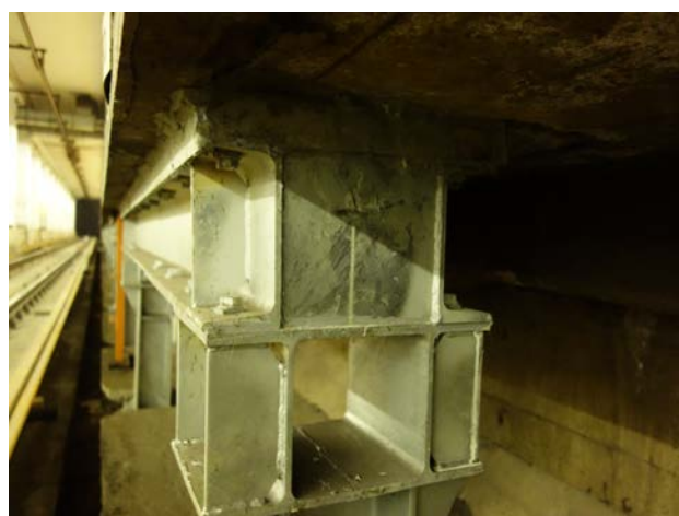
写真-6 桁上部とホームスラブの隙間での高さ調整
