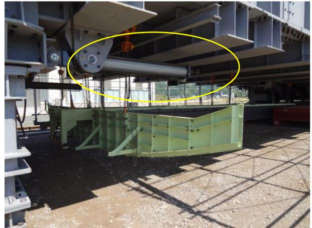
写真-2 栈橋移動用油圧シリンダー
