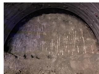
図-15 切羽写真（風化礫岩、谷ヶ山トンネル）
