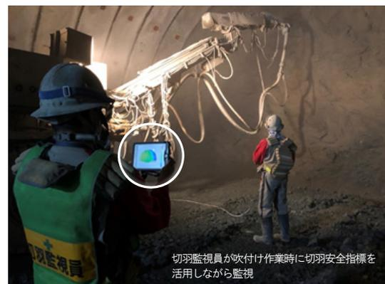
図-8 切羽監視員による切羽監視状況
