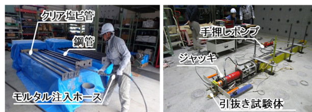
写真-5 引抜き試験状況
