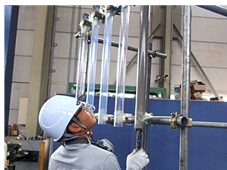
写真-4 ロックボルト上向き打設状況
