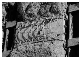
写真-1 hiDCon の施工事例 4)
