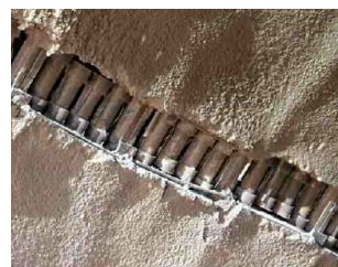
写真-2 LSC の施工事例 5)
