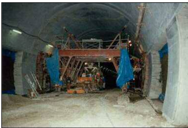
写真3 側壁コンクリートの打設状況
