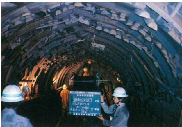
写真-1 矢板工法トンネルのイメージ
