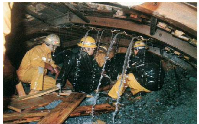
写真-2 矢板工法の湧水处理
