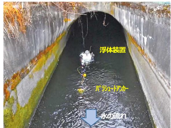
写真4 浮体装置の流下状況（トンネル部出口）
