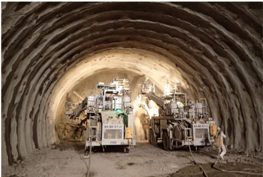
写真-2 本坑掘削状況
