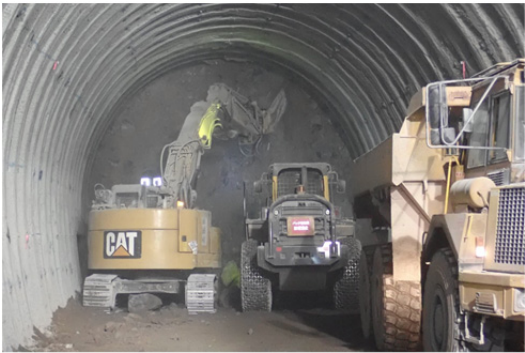
写真-1 避難坑掘削状況
