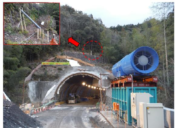
写真-12 終点側坑口部 斜面監視状況
