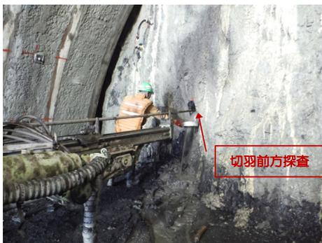
写真-5 切羽前方探査 実施状況 (終点側)
