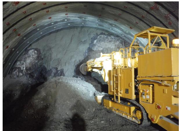
写真-1 トンネル掘削状況<sup>1)</sup>
