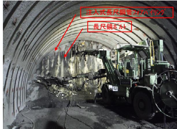
写真-8 トンネル施工状況（補助工法）<sup>1)</sup>
