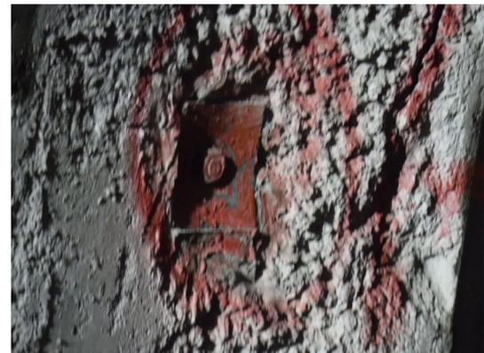
写真-4 トンネル支保変状状況<sup>2)</sup>
