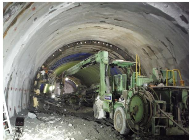
写真-10 注入式フォアポーリング施工状況
