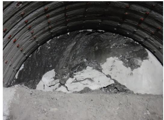
写真-3 鏡吹付滑落状況<sup>2)</sup>
