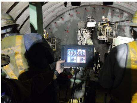
写真-6 切羽前方探査 実施状況 (起点側)<sup>2)</sup>
