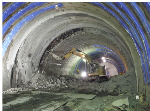
写真-9 縫返し掘削状況
