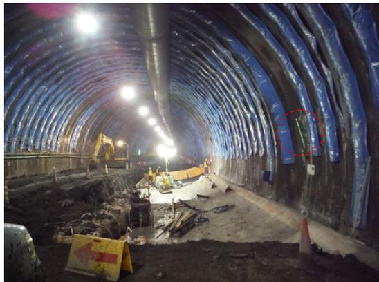
写真-14 インバート片側施工時監視状況
