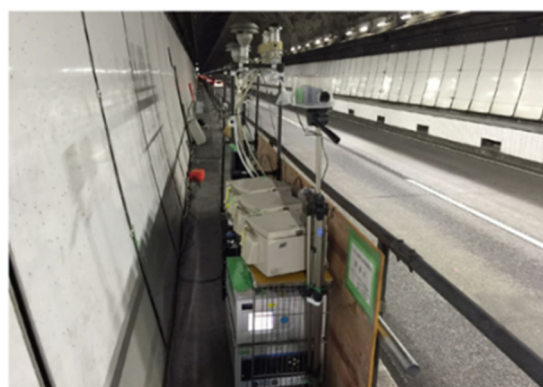
図-3 調査機器設置状況
