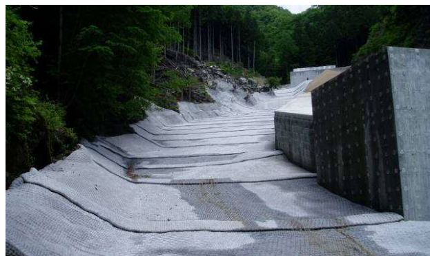
写真-2 布製型枠施工例
