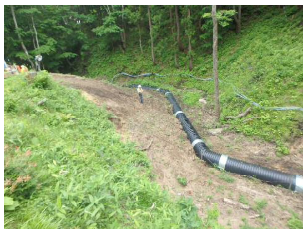
写真-3 仮設暗渠管による沢水切り回し
