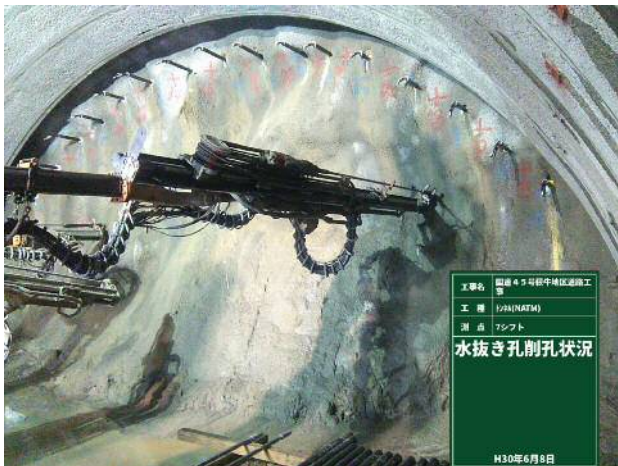
写真-5 水抜き孔削孔状況
