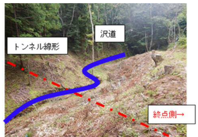
写真-1 小土被り部直上部
