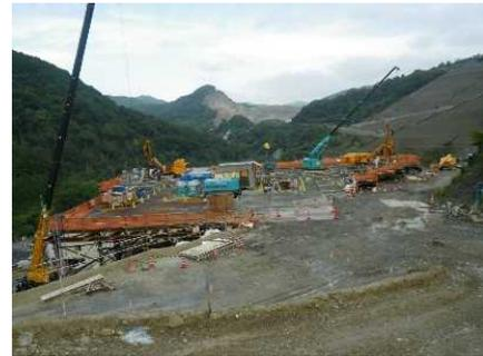
写真-2 高圧噴射攪拌工法（作業構台）
