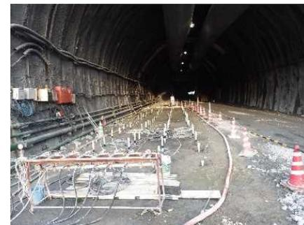
写真-4 薬液注入工法（坑内）
