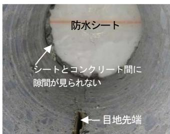
写真-3 天端部のコア抜き後の内部
