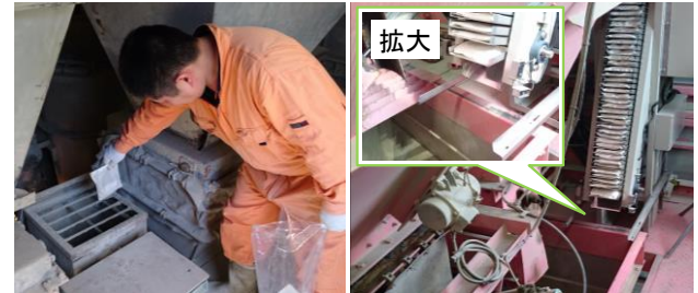
写真-2 現状の特殊増粘剤の投入状況 (左: 手動, 右: 自動)
