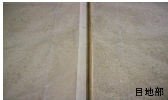
写真-7 高流動コンクリートで構築した覆工の外観
