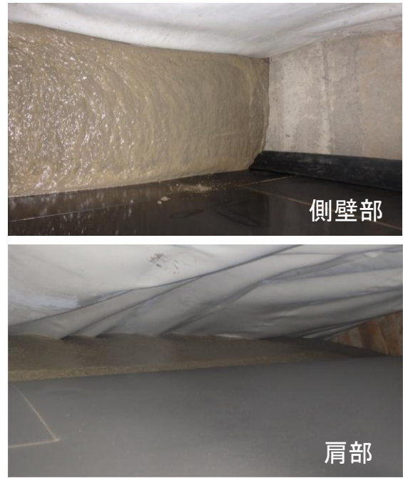
写真-6 高流動コンクリートの流動状況
