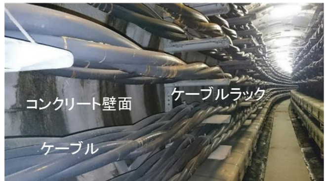
写真-1 送電用トンネルの状況
