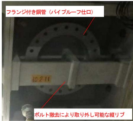
図-16 トンネル内側より撮影したパイプ仕口部
