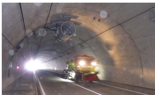
写真-2 車両の通行状況
