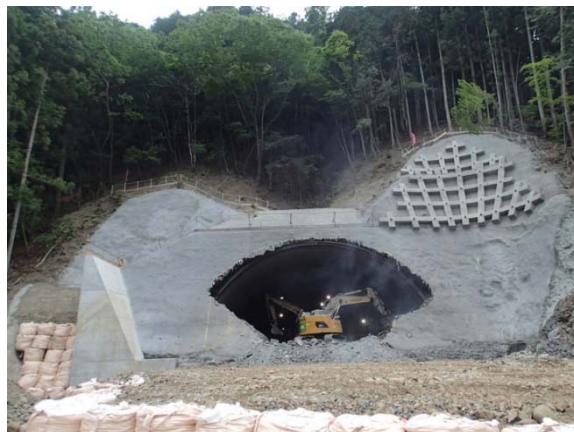
写真-3 終点側坑口上半掘削状況
