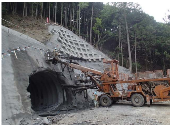
写真4 長尺鋼管フォアパイリング施工状況
