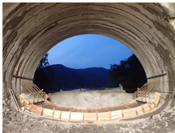
写真5 掘削最大断面226m 2
