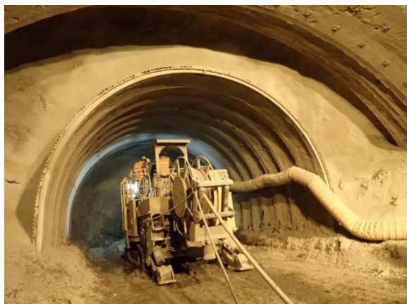
写真-2 先進導坑掘削状況
