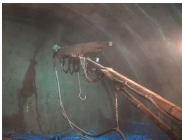
写真-4 はね返り量試験状況
