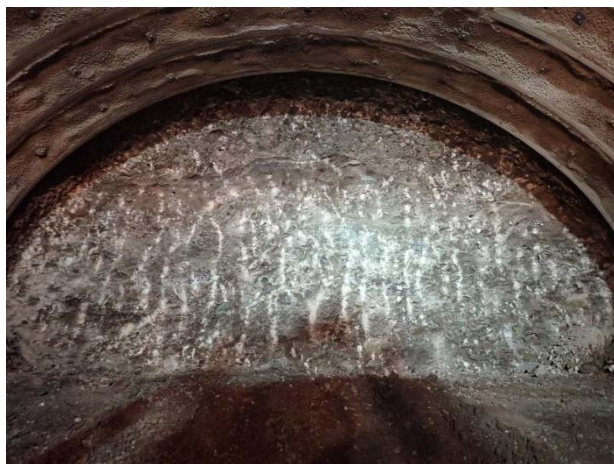
写真-2 試験施工時切羽状況
