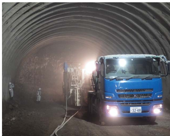
写真-5 試験施工時坑内状況
