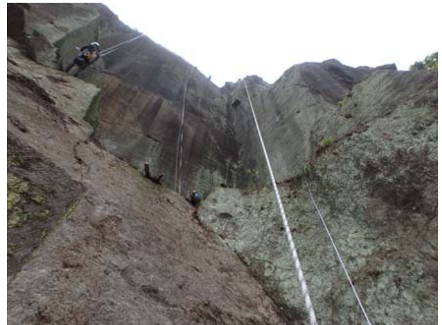
写真-3 法面状況(鉛直箇所)
