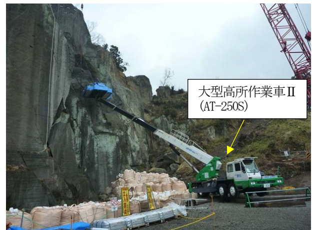
写真6 高所作業車 II 使用状況
