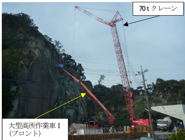
写真4 大型高所作業車 I 使用状況
