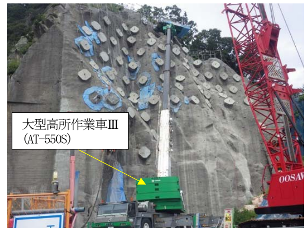
写真7 高所作業車 III 使用状況
