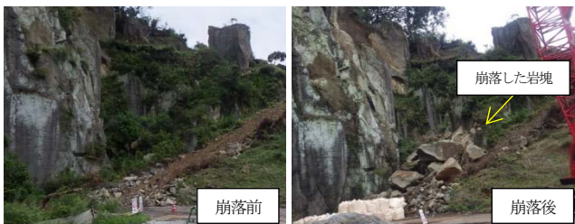
写真-2 岩塊崩落状況
