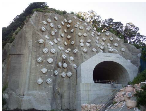
写真-10 法面全景(施工完了後)
