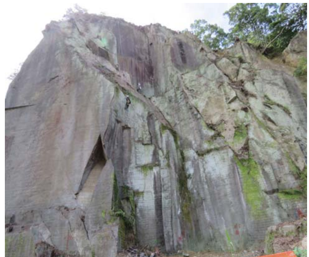
写真-1 法面状況（伐採後）
