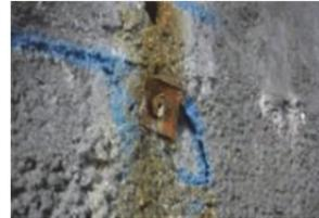
写真4 B.吹付けコンクリートのひび割れ
