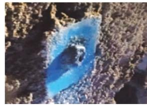
写真3 A.ロックボルトプレートの曲り
