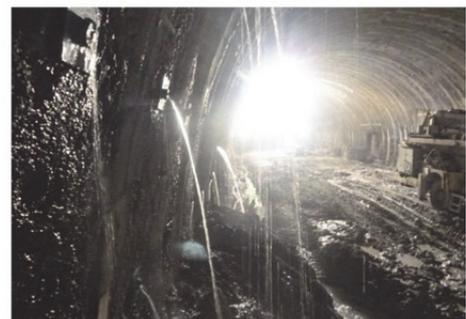
図6 縦断方向に続く断層破砕帯 (その1)
