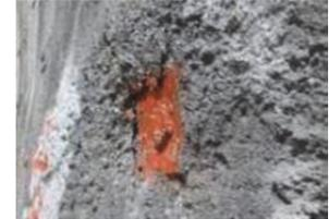
写真5 C.ロックボルトのプレートの破断
