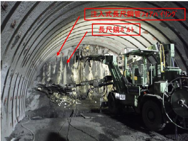
写真-7 トンネル施工状況（補助工法）
