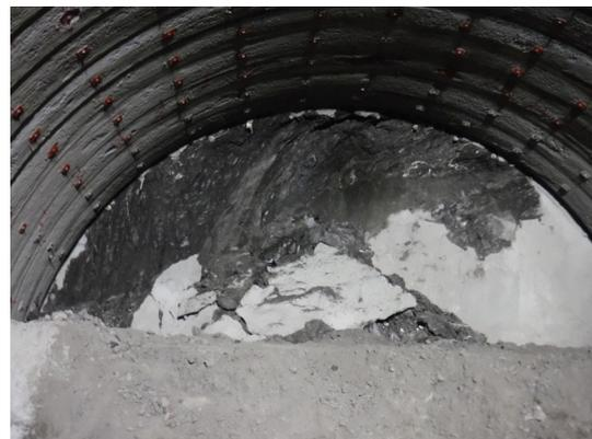
写真-3 鏡吹付滑落状況
