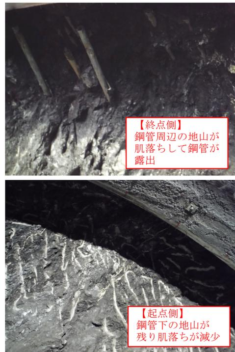
写真-6 鋼管下の肌落ち状況
