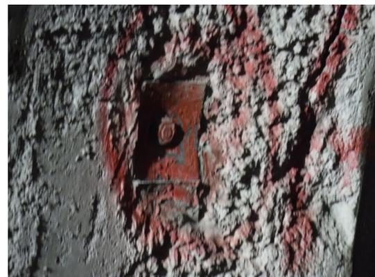
写真-4 トンネル支保変状状況
