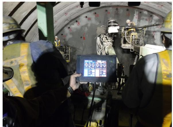
写真-1 切羽前方探査 実施状況
