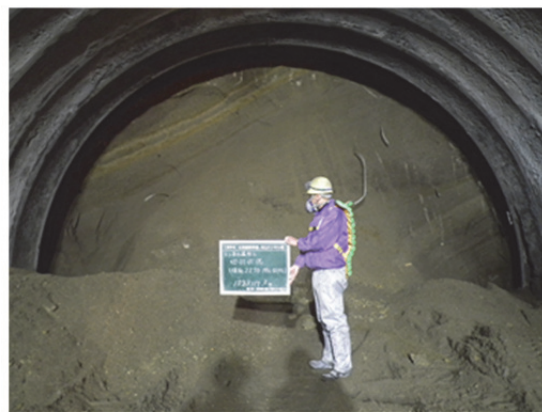
写真-3 AGF-R施工時の切羽状況
