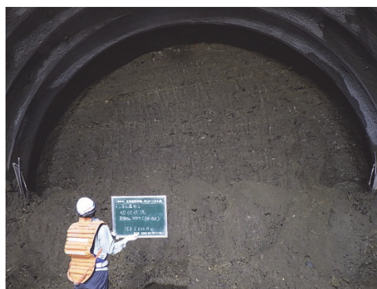
写真-4 現在の切羽(富川層基底部)
