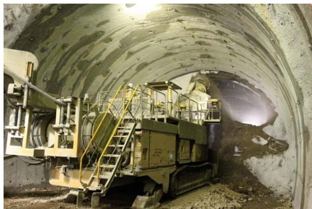
写真-5 砂礫層区間でのトンネル貫通
