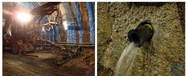
写真-3 水抜き・探りボーリング状況
