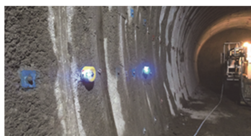
写真-2 受振ユニット設置状況
