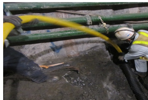
写真-2 保護管への計器挿入状況
