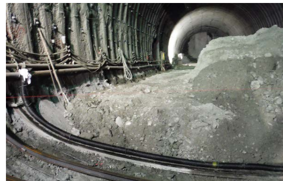
写真-1 インバートストラットへの設置状況
