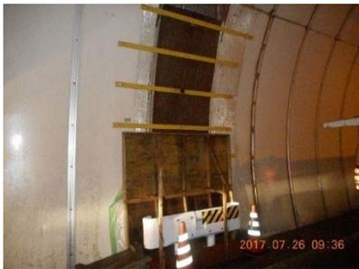
写真-3 応急措置（当て板工+平鋼（アンカー併用））
