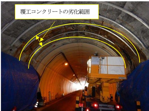
写真-9 面導水パネル撤去後の覆工コンクリートの状況
