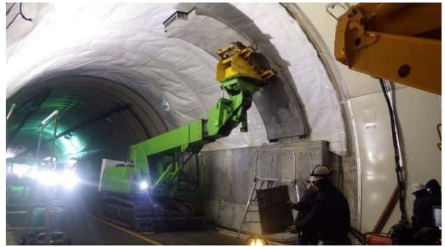
写真-10 スピンアームによるPCLの設置状況
