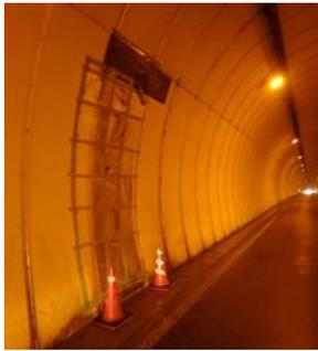
写真-1 応急措置状況（面導水パネル一部撤去，緊急点検時）
