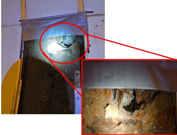
写真-2 覆工面の状態（緊急点検箇所）
