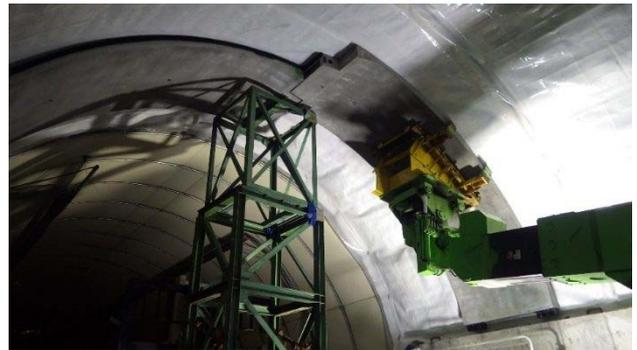
写真-11 受台を用いたPCL板の設置状況
