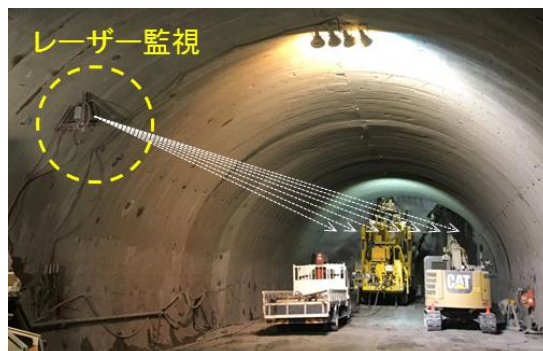
写真-1 レーザー距離計による切羽の計測状況
