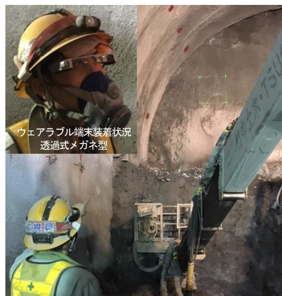
写真-6 切羽監視状況とウェアラブル端末使用状況
