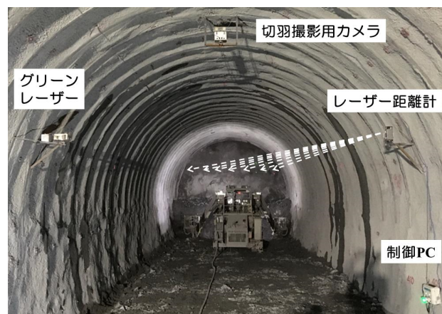
写真-3 現場適用時の機器配置状況
