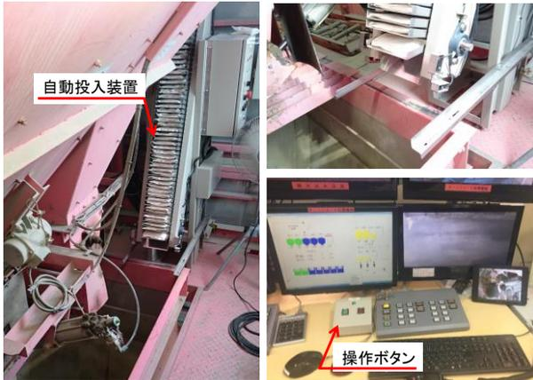
写真-7 特殊増粘剤の自動投入装置の外観
