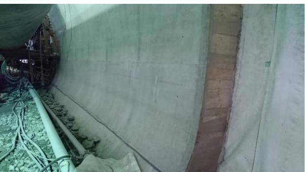
写真-9 高流動コンクリートで構築した覆工の仕上がり状況
