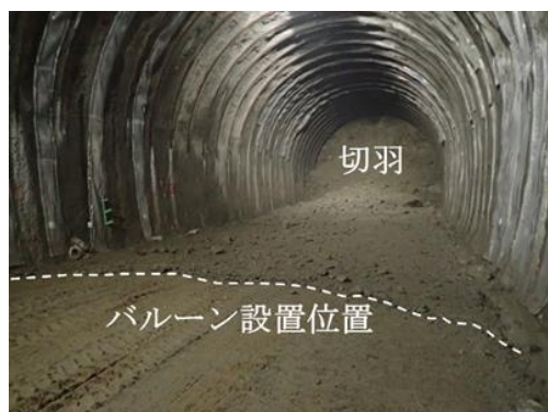
(a) 坑口側から観た様子
