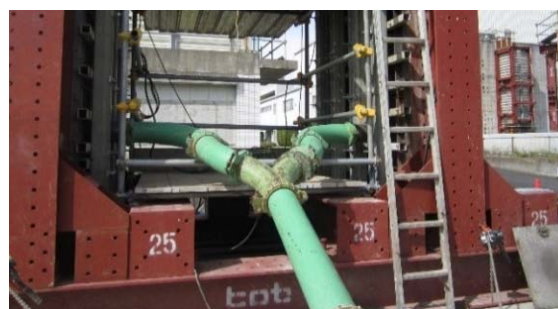
写真-2 配管状況 (分岐部)
