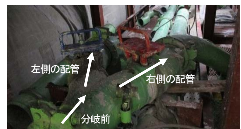
写真-6 配管分岐部の状況
