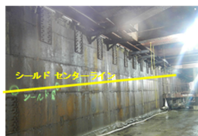
写真-8 土留め壁内面鋼板補強状況
