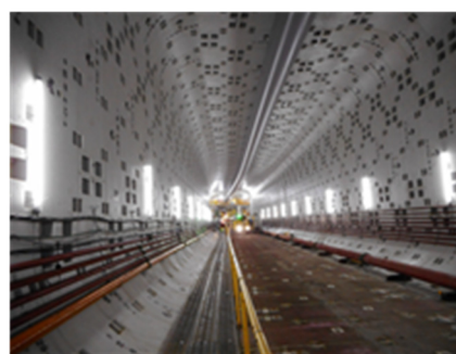
写真-11 坑内全景
