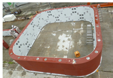
写真-2 セグメント水平仮組検査状況
