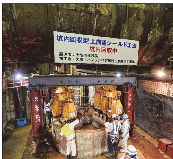
写真-3 上向きシールド機坑内回収状況①
