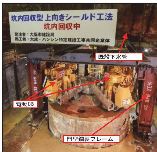
写真-2 マシン吊降ろし設備設置状況
