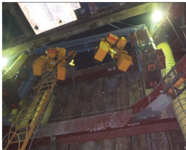
写真-1 マシン吊降ろし設備立坑投入状況
