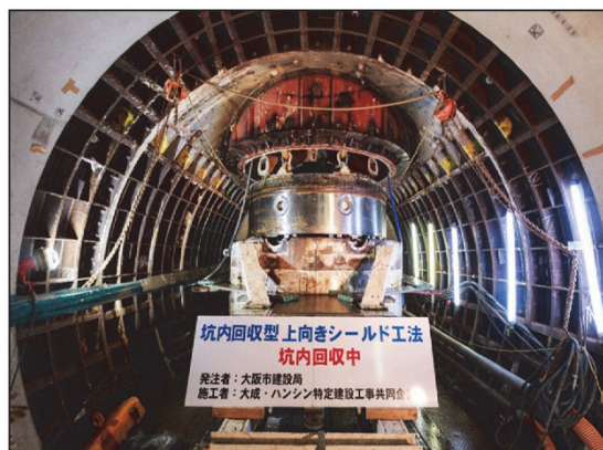
写真-5 上向きシールド機坑内回収状況③
