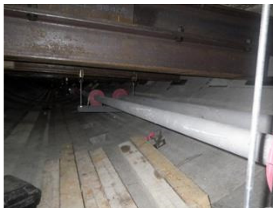
(b) 枕木配管
