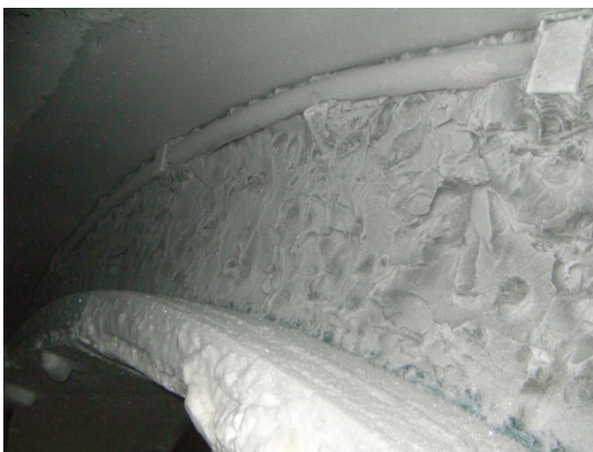
写真-7 凍土造成状況の様子
