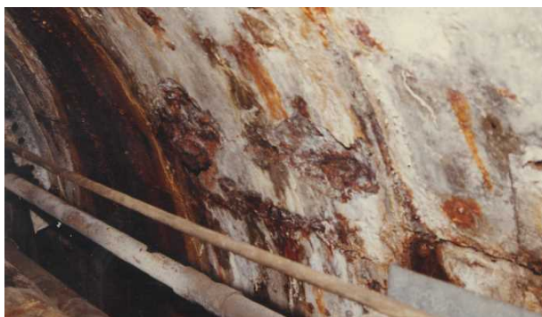
写真-1 セグメント表面状況 (1984年)
