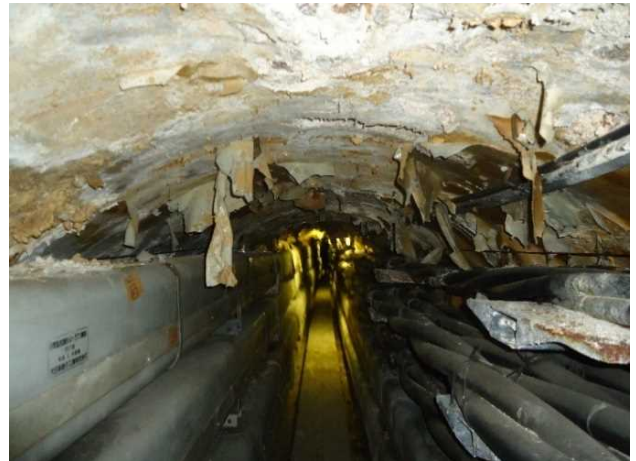
写真-2 トンネル内部状況 (2016年)
