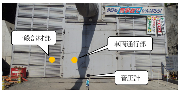
写真-1 測定対象としたコンクリート2層式防音扉
